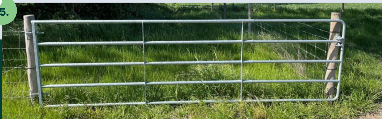
Figur 5: De nuværende porte består af en grov rørkonstruktion, der ved udsætning af svin skal forsynes med 3 strømførende tråde samt aflåses eller alternativt forsynes med supplerede færiste.
