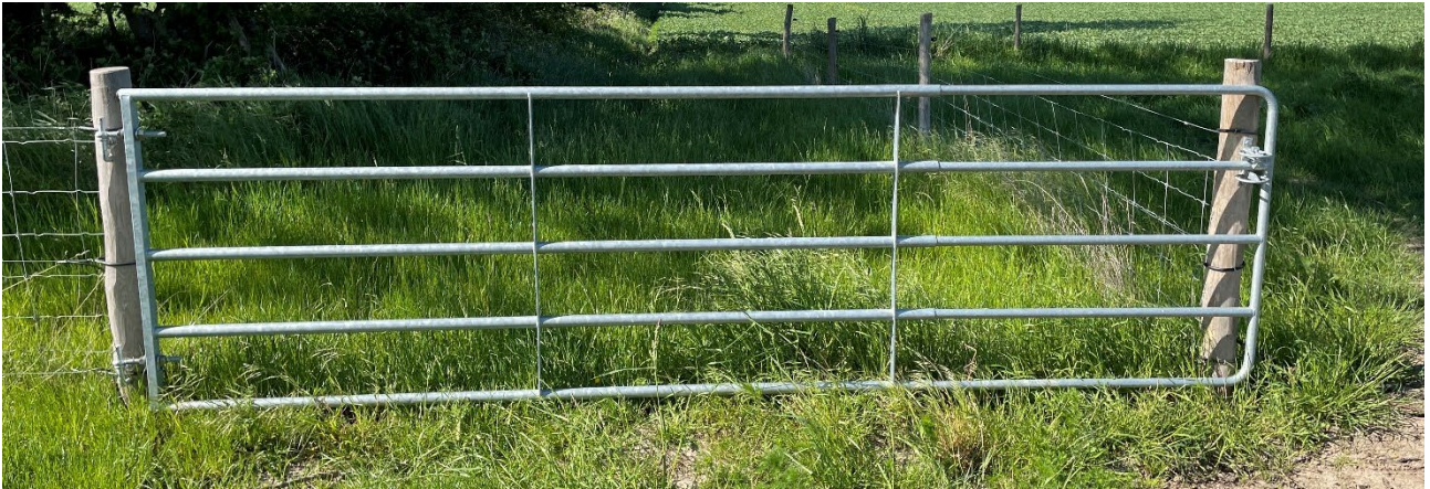
Figur 5: De nuværende porte består af en grov rørkonstruktion, der ved udsætning af svin skal forsynes med 3 strømførende tråde samt aflåses eller alternativt forsynes med supplerede færiste.
