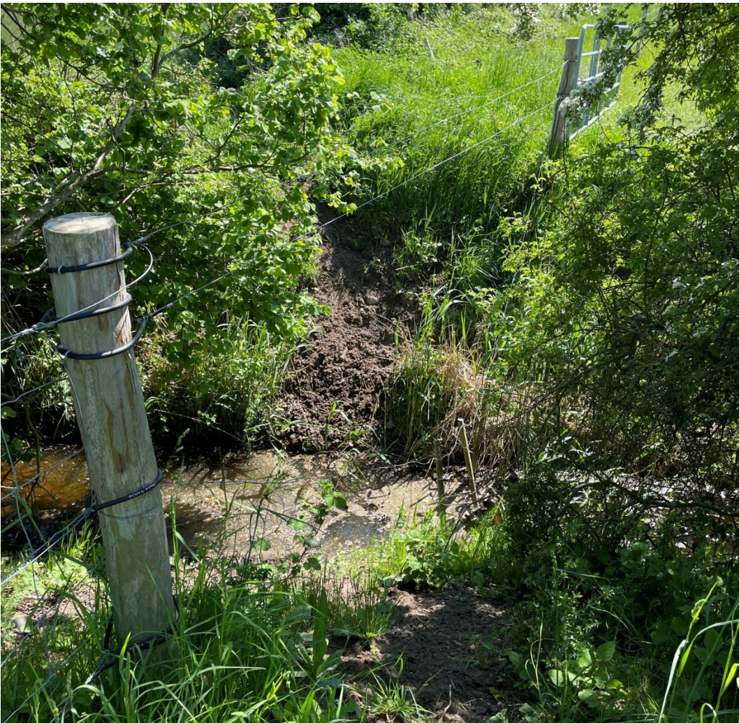
Figur 8: Flere eksisterende vandløbskrydsninger skal opgraderes, så de kommer til at udgøre en tilstrækkelig sikker barriere for svin, men samtidigt ikke hindrer vandets frie løb.
