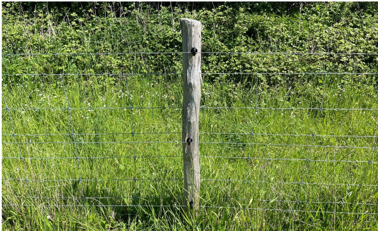
Figur 1: Nuværende hegnstype med ydre nethegn, hvor der på indersiden af hegnets stolper er monteret 3 strømførende tråde. Indhegningen har en samlet højde på 110 cm.
